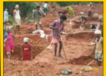
De fundering wordt met handen gegraven.
